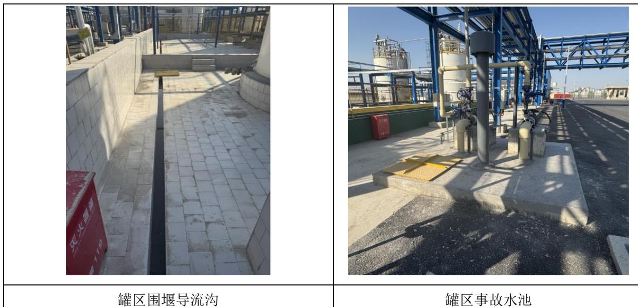
**二级防控措施：**已建成 1 座 1332m<sup>3</sup>事故水池、1042m<sup>3</sup>初期雨水池，用于消防废水、初期雨水、事故处理废水的暂存；罐区已设置导排系统及切换阀门。
